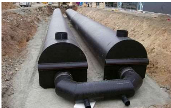
Figur 14. Exempel på dagvattenkassetter för fördröjning/infiltration av dagvatten. Kan anläggas under körbara ytor (Uponor 2021-08-17)
