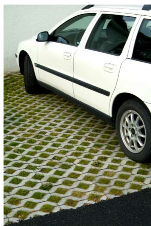
Figur 8. Gräsarmering – gräsmunk till parkeringsytor (S:t Eriks 2021-08-17)
