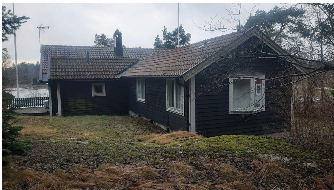
Baksidan av Thorsborg. Berg i dagen framträder tydligt i bildens nederkant. Även på andra sidan Thorsborg, ned mot vattnet, framträder berg i dagen (se bild på sida 8).
