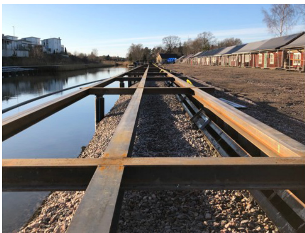
Stålkanten vid Femöre kanal är färdig. Här har arbetet med att iordningsställa brygga och promenadsstråk påbörjats.
