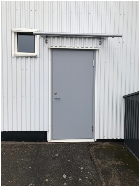
Plåtdörr likt befintlig (se bilderna)
