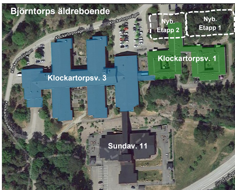
Figur 1. Björntorps äldreboende med Klockartorpsvägen 1 (grönmarkerad) och Klockartorpsvägen 3 (blåmarkerad) samt Sundavägen 11 (grå). Streckade i överkant avser nybyggd etapp 1, samt planerad etapp 2 (Klockartorpsv. 1F resp. 1G).
