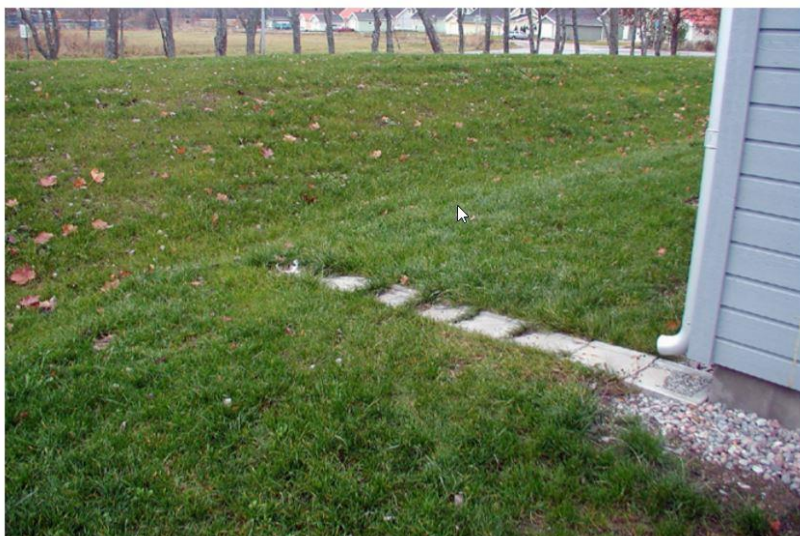
Figur 22. Stuprör med utkastare. Bildkälla: WRS via SVOA (u.å.c).
