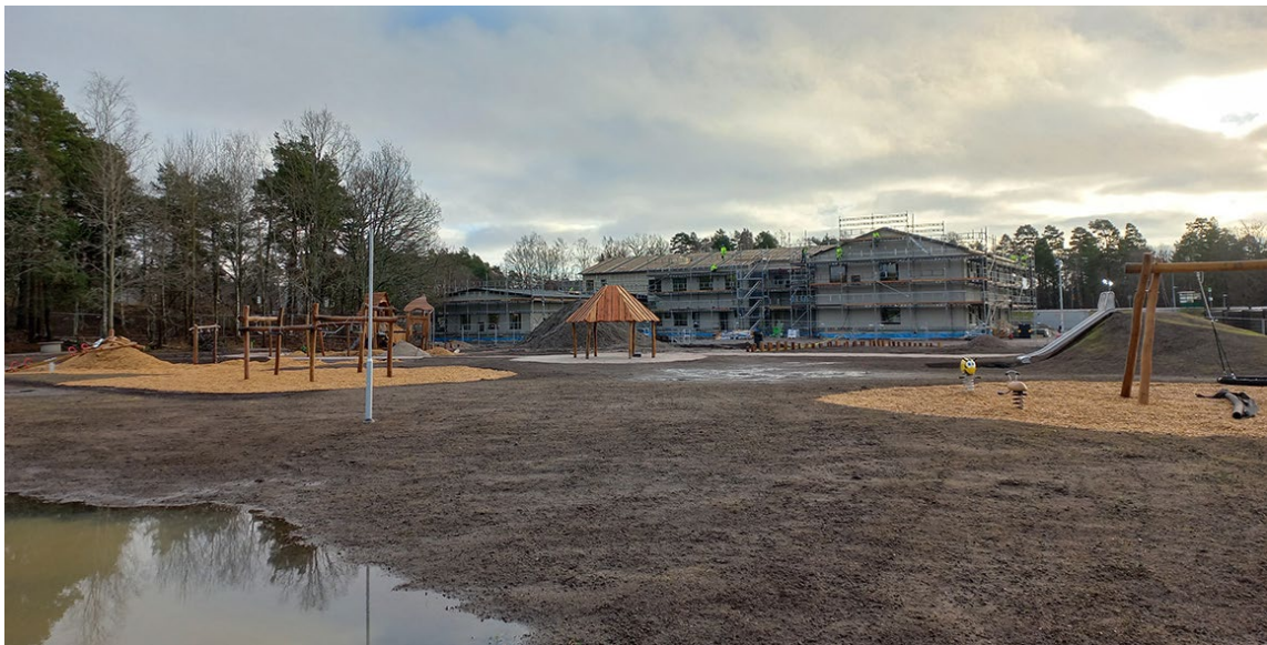
Pågående byggnation sedd från gång- och cykelvägen i norr. I vänstra hörnet syns den skogsdunge som också blir en del av skolgården. Viss lekplatsutrustning var på plats vid fototillfället i februari 2023.
