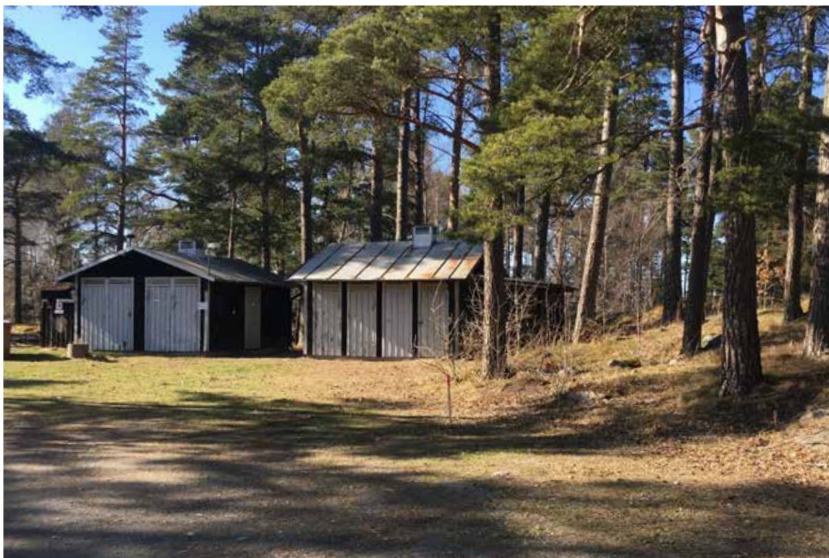
Dassbyggnad och latrinförråd.
